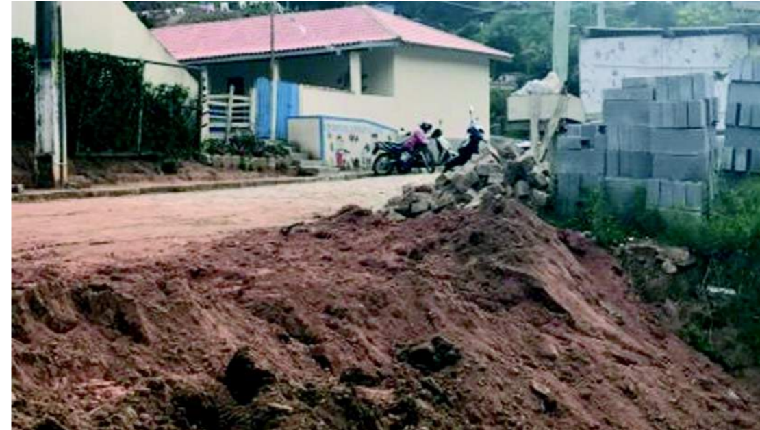
Obra realizada em São José do Ribeirão
